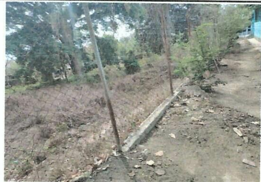
Foto 4: Sustitución de tubos hg.
