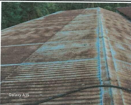
Foto 5: Sustitución de capote.
