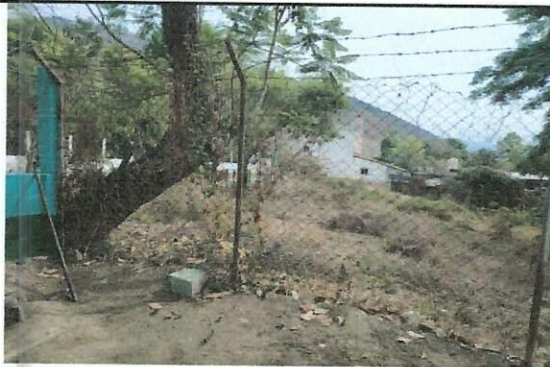
Foto 3: Reparación de muro perimetral con malla galvanizada.
