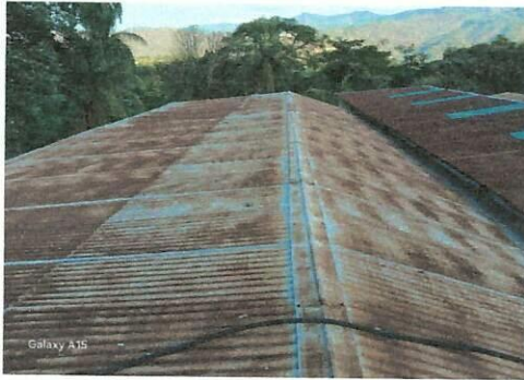
Foto 1: Cambio de techo con lámina troquelada.
